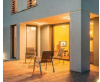
Abitazioni prefabbricate in legno Prefabricated homes Wood
